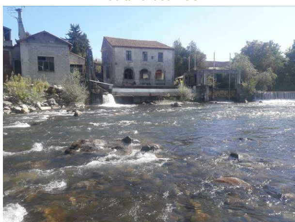
Vue centrale du TCC
